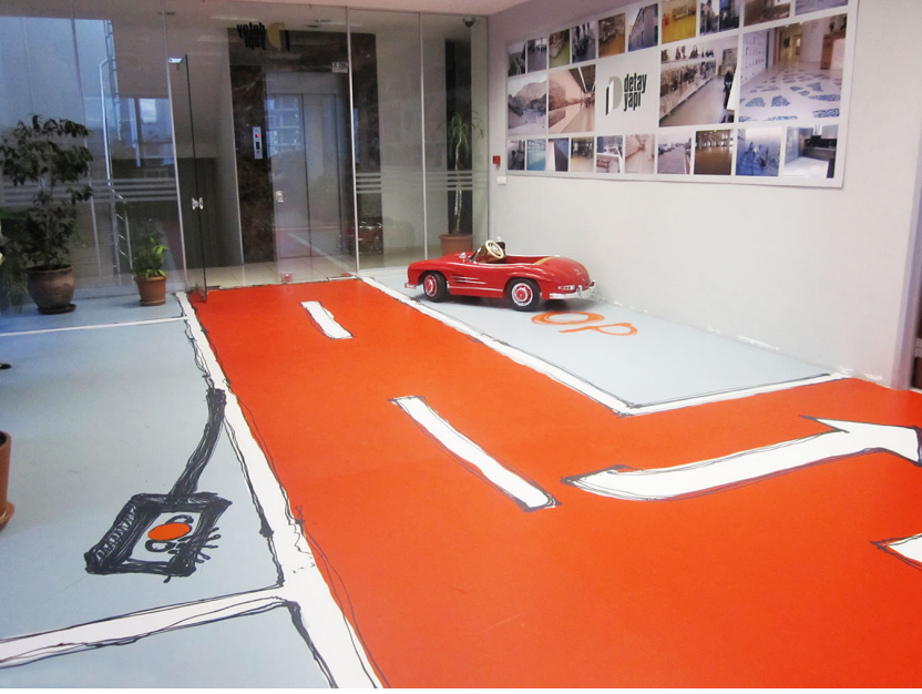
Resim 9: Poliüretan Zemin Uygulaması Örneği, (Detay Yapı, 2020)
